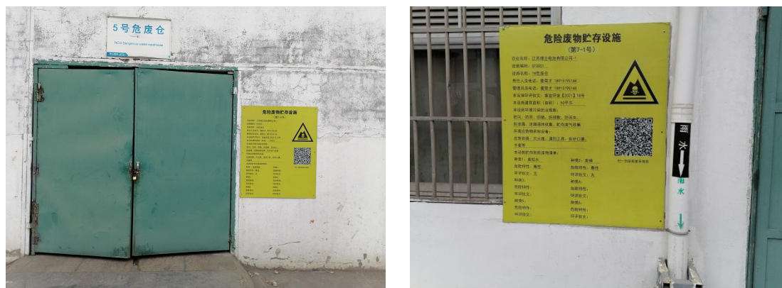
图 4.1-4 危废仓库现场情况
