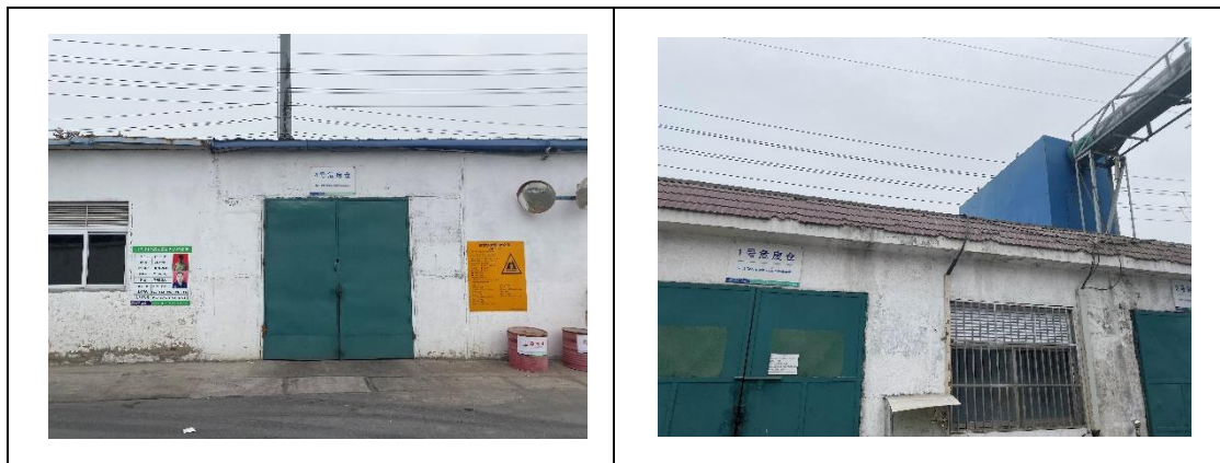
图 4.1-2 危废仓库现场照片
